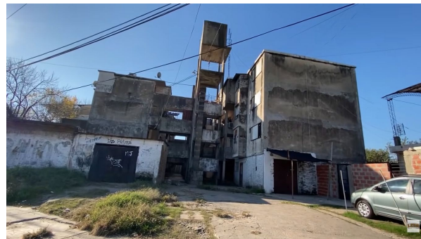
Complejo habitacional de 4 pisos - Completamiento de construcción informal
